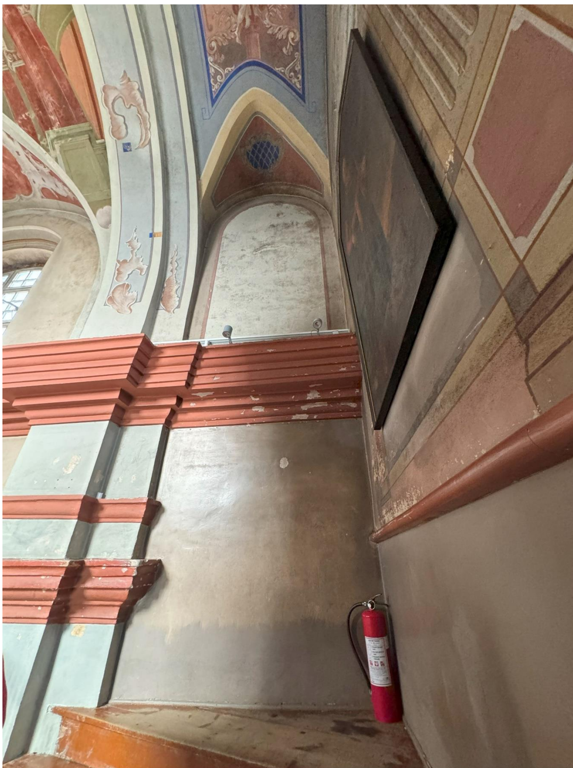
18. Choristų vieta, sienų tapybos paviršius padengtas nešvarumais, paviršiai pažeisti mechaniškai, sienų apačia dažyta aliejiniais dažais.
