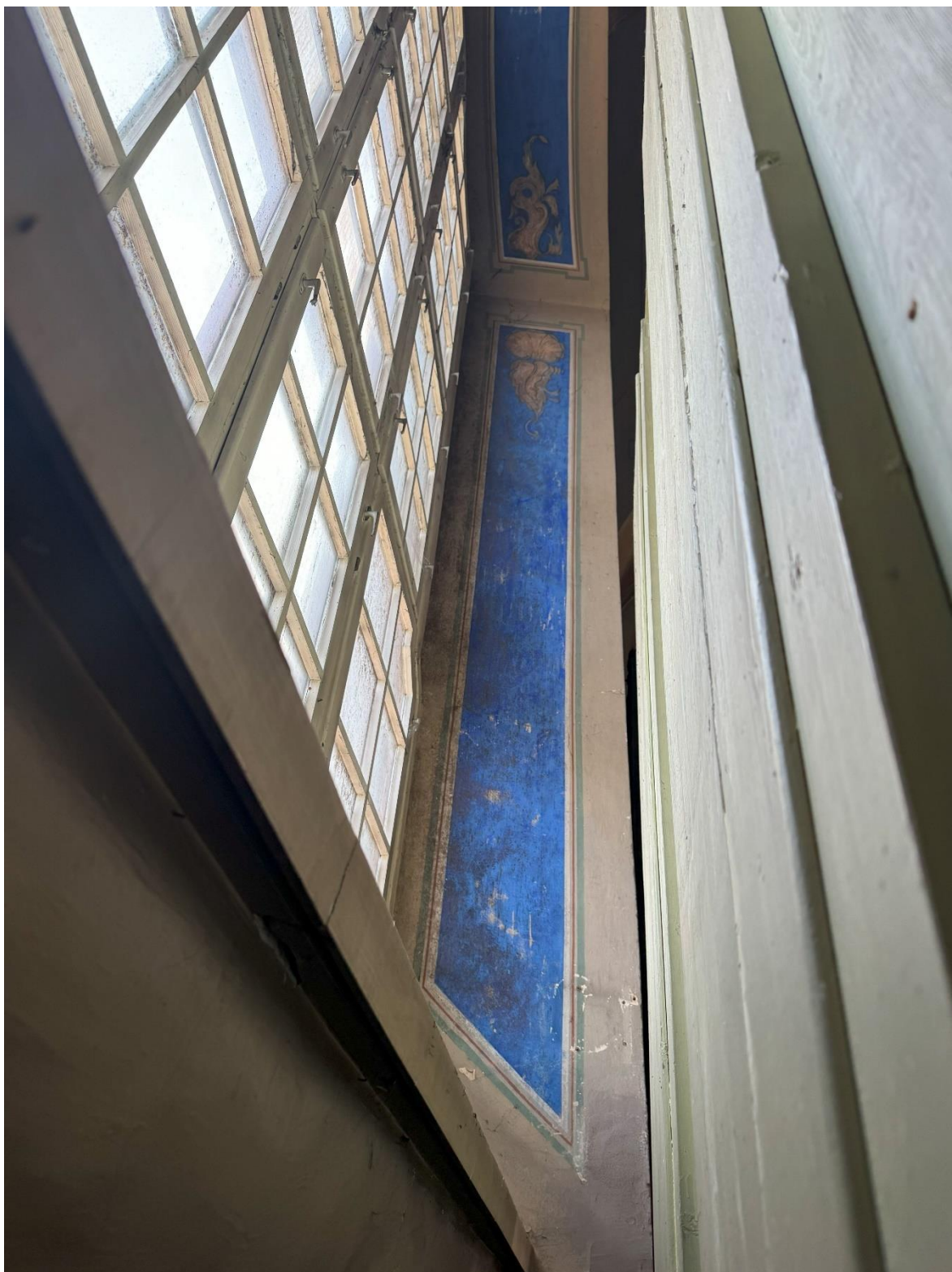
16. Lango angograščio tapybos paviršius padengtas su nešvarumais ir pelėisiais
