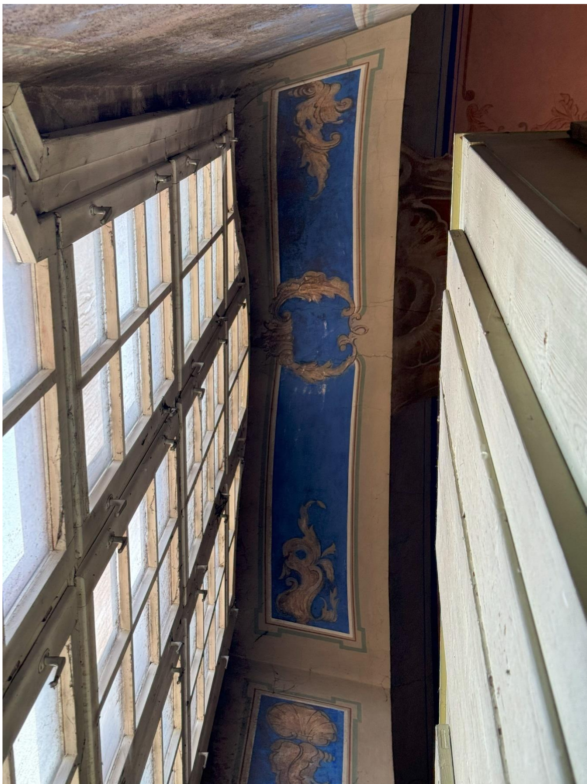
17. Lango angograščio tapybos paviršius padengtas su nešvarumais ir pelėisiais
